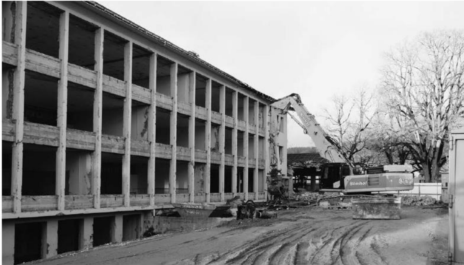
Noch steht das Gerippe des alten Sekundarschulhauses Zentrum. «Eine Sanierung des Gebäudes wäre wirtschaftlich nicht sinnvoll gewesen», sagt der Präsident VSGDH und Baukommissionspräsident Hansruedi Stör.
